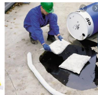
Exemple d'utilisation d'un kit d'intervention anti-pollution (HALECO)
