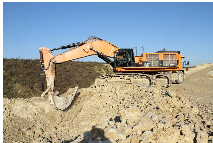
Pelle hydraulique utilisée pour l'extraction du gisement (ENCEM)
