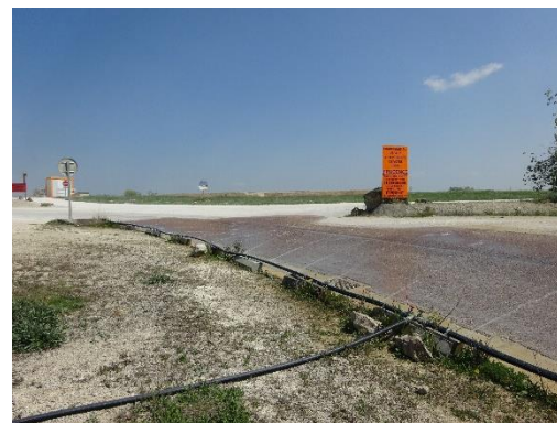
Arrosage de l'entrée du site avec des sprinkler pour réduire les envols de poussières (ENCEM)
